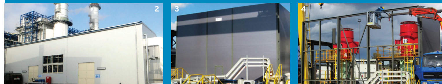
1. Προμήθεια, εγκατάσταση Ηχομονωτικών Panel σε κτίριο Ηλεκτροπαραγωγής στο Μπράζι Ρουμανίας (15.000m 2 /ΜΕΤΚΑ) Supply & installation of acoustic panels in Power plant at Brazi Romania (15.000m 2 / METKA) 2. Μελέτη - Προμήθεια - Εγκατάσταση Panel Βιομηχανικού κτιρίου / Study - Supply - Erection of Industrial building Panel 3.& 4. Κατασκευή βιομηχανικού ηχοπετάσματος ειδικών προδιαγραφών, ΔΕΗ - Αλιβέρι / Erection of special industrial noise barrier, PPC - Aliveri
